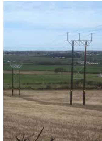
132kV wood pole
